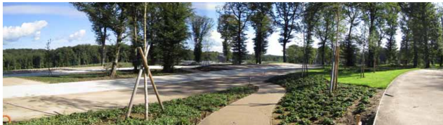
Les cheminements piétons en Terraway® (matériau de sol poreux) guide le voyageur vers le bâtiment de la gare. Des plantations de couvre-sol l'encadre afin de canaliser le flux des utilisateurs. Les plantations de vivaces ont 4 mois, leur reprise est assurée.
